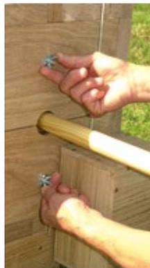
Schrauben lösen, dann kann die auf der Innenseite der Falle befindliche Rückwand als Schiebeprett benützt werden
